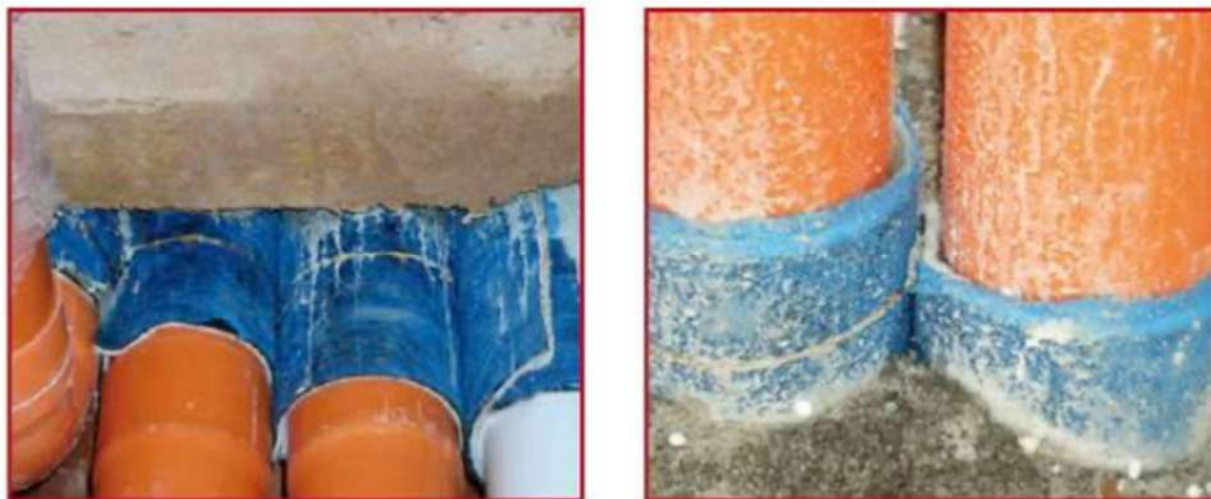
Fig. 23: particolare di tubi ricoperti con guaine isolanti al passaggio di muri e solette
