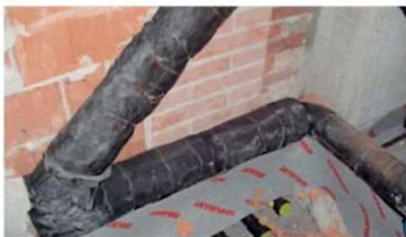
Fig. 25: particolare isolamento tubi
